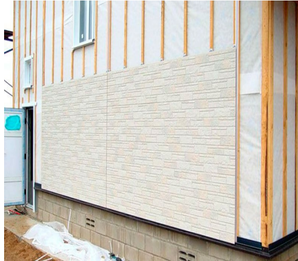
Рисунок 2 Вентилируемый фасад из фиброцементных плит
